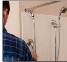
Instalamos barras de sostén para su seguridad.
