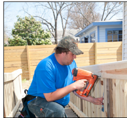
Instalamos rampas para que acceda a su casa facilmente.
