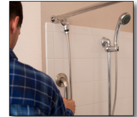
Instalamos barras de sostén para su seguridad.
